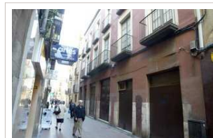
La façana de l'edifici es conservarà. Els interiors s'enderrocaran i es faran de nou. Foto: JUDIT FERNÁNDEZ
